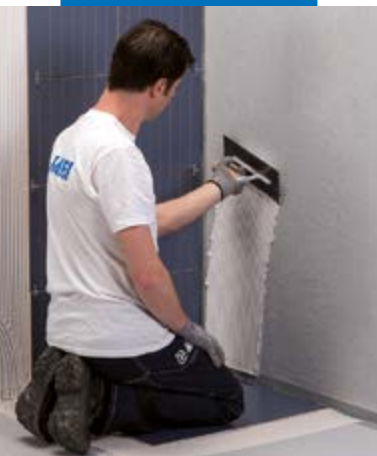
Aanbrengen van wandbekleding met Keraflex Maxi S1
