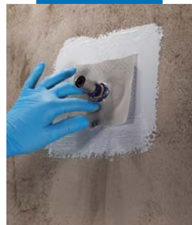
Aanbrengen van een Mapeband PE 120 afdichting voor doorlopende gaten met Mapegum WPS
