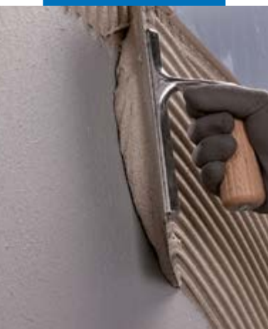
Aanbrengen van vloerbedekking met Ultramastic III
