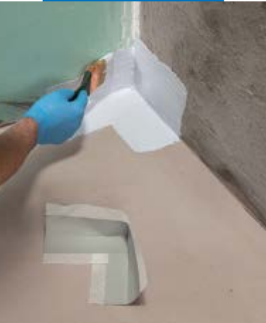
Het aanbrengen van een 90° Mapeband PE 120 hoekstuk met Mapegum WPS
