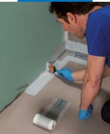
Aanbrengen van Mapeband PE 120 met Mapegum WPS
