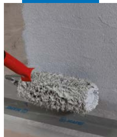
Aanbrengen van Mapegum WPS met een roller
