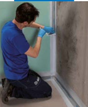
Aanbrengen van Mapeband PE 120 met Mapegum WPS
