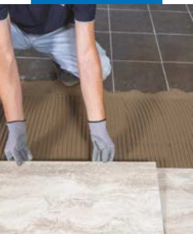
Op een bestaande vloer aanbrengen van vloertegels met een steeneffect
