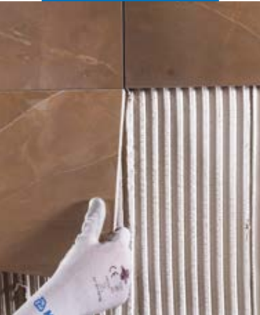
Aanbrengen van keramische wandtegels
