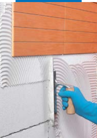
Keramastic op de ondergrond aanbrengen
