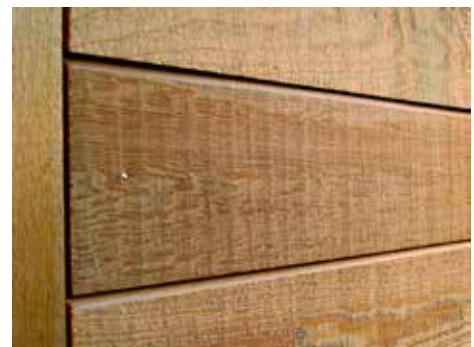
Afbeelding 1. Voorbeeld open gevelbekleding.
